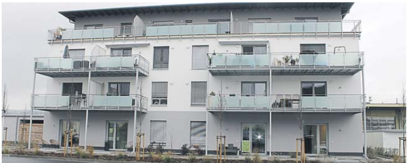
Das Gebäude beherbergt vier Gewerbeeinheiten und elf Mietwohnungen.
