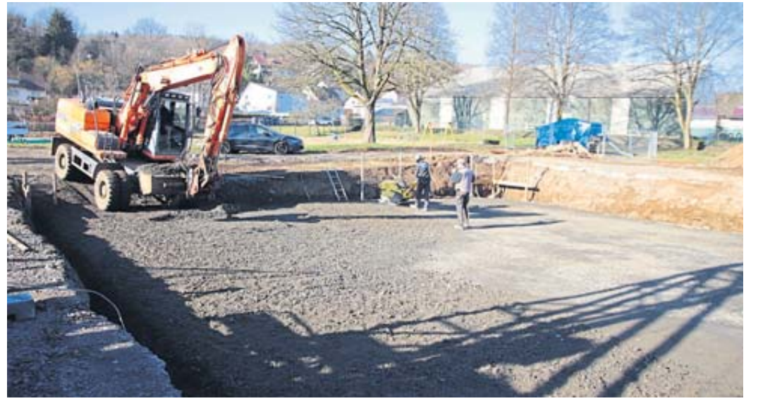
Derzeit sind Bauarbeiter mit der Herstellung der Bodenplatte für die künftigen Sanitär- und Umkleieräume im hinteren Bereich des Freibades beschäftigt.. Fotos: Stadt Schlüchtern
