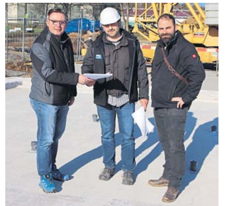
Sie freuen sich über den guten Fortgang der Arbeiten im Freibad Schlüchtern (von links): Mario Zirkel von der Stadtentwicklungsgesellschaft, Ralph Klein von der Firma Philipp sowie Daniel Storbeck vom Planungsbüro IWTI stehen im künftigen Nichtschwimmerbecken.
