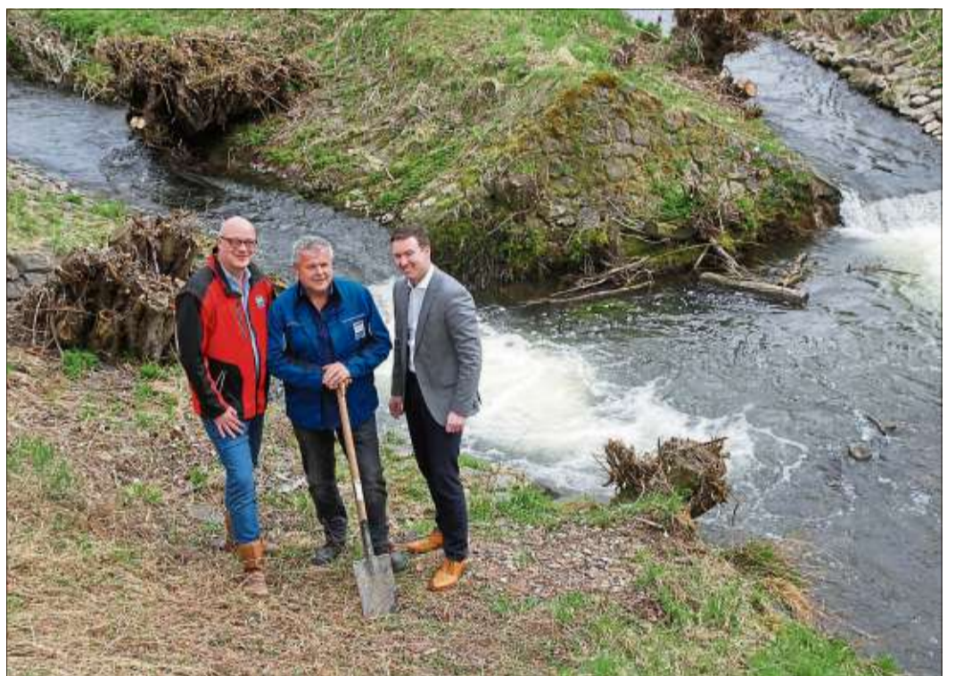
Trasseningenieur Marco Breiding beim Spatenstich mit Bürgermeister Matthias Möller und Bauleiter Stephan Ehwald.
