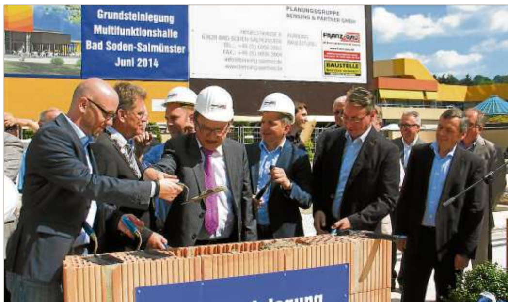
Bewiesen handwerkliches Geschick bei der Grundsteinlegung: Bundestagsabgeordneter Dr. Peter Tauber, Landrat Erich Pipa und Jürgen Franz vom Bauunternehmen (vorne von links).
