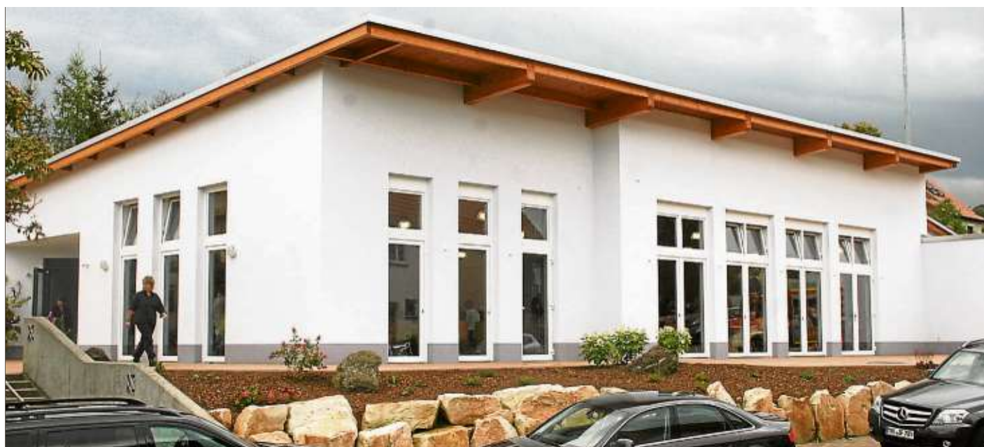
Das funktionelle Gemeinschaftshaus verfügt über einen großen Saal mit knapp 160 Quadratmetern, einen Dorftreff mit 70 Quadratmeter und einen kleinen Saal mit 75 Quadratmeter.
